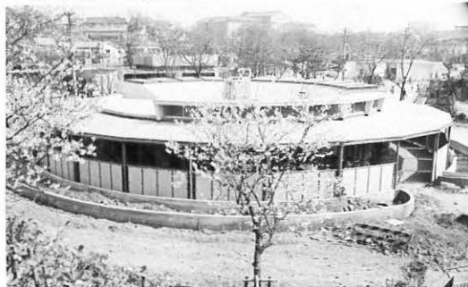
完成したハ虫類舎
