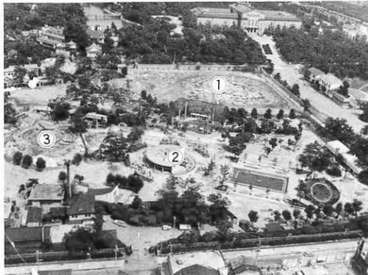
① 建設中のカモシカ園 ② 建設中のゴリラ舎 ③ 建設中の類人猿舎
