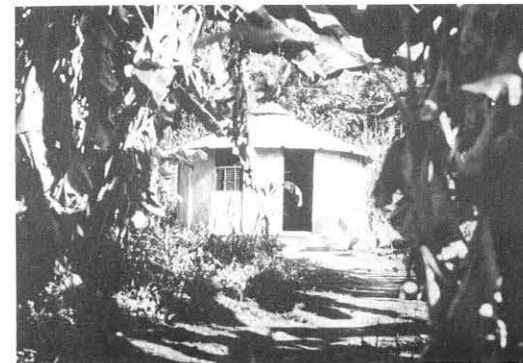
バナナ畑の中にある研究所。以前の泥壁の家にくらべるとずっと近代的になったが、日中トタン屋根があつて中で仕事はできない。
