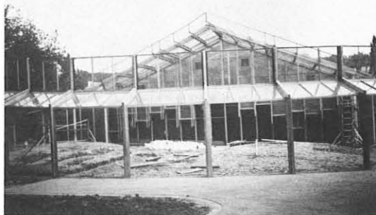
完成間近の新類人猿舎
