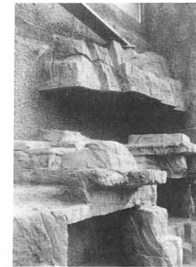
⑧ 擬岩のモルタル吹付が終わりました。
