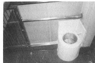
⑩ 寝室内のステンレスシャッターと水飲器。
