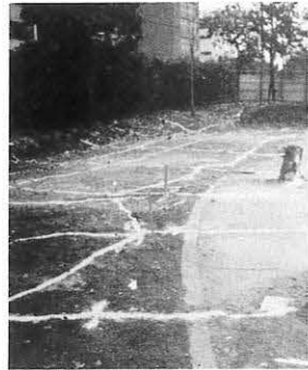
② 整地を行い位置出しを行いました。
