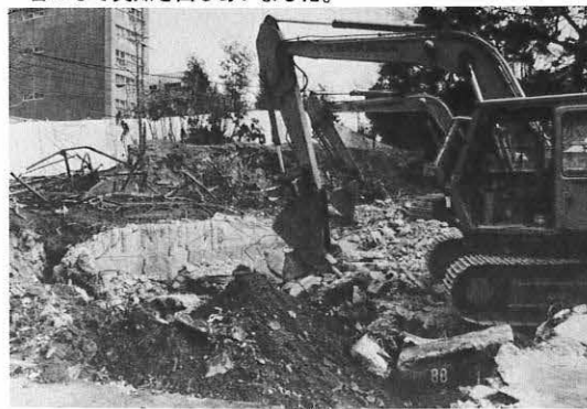
旧小獣舎の解体がはじまりました。いよいよヒョウ舎の建設です。
