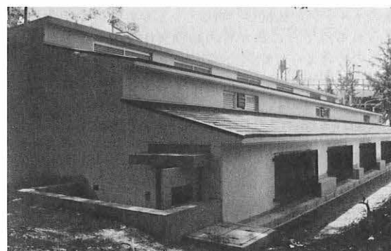
ヒョウ舎の裏側、風通しの良いようにガラリ、換気扇が 設けられています。
