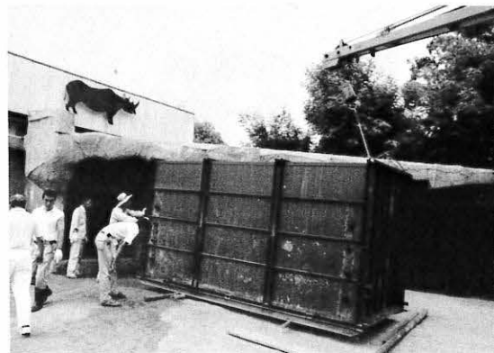
① カラ檻を動物の出入口に据付ける。空でも1トン以上ある丈夫な鉄檻はクレーンの力をかりる
