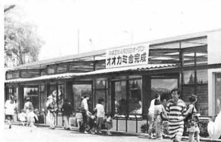
完成した新オオカミ舎
