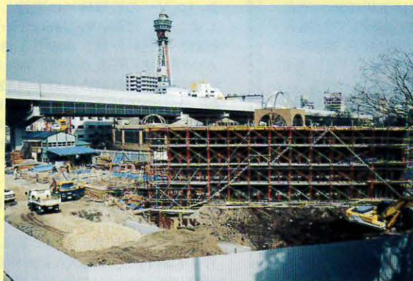
3月 右側はチンパンジー舎建設用の足場で、左側は基礎作りの始まったオランウータン舎です。
