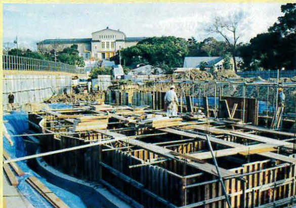
1月 まずは、チンパンジー舎の建設から始めました。写真は建物の基礎を作っているところです。
