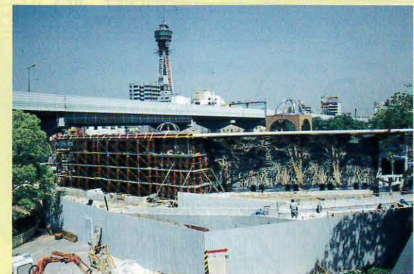
5月 オランウータン舎の高い足場は、高いオリを作るためのものです。チンパンジー舎手前は2階建の観客通路です。
