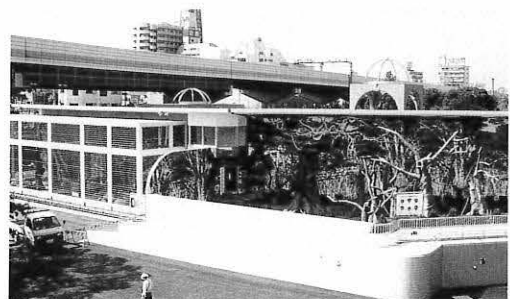
完成した新チンパンジー・オランウータン舎
