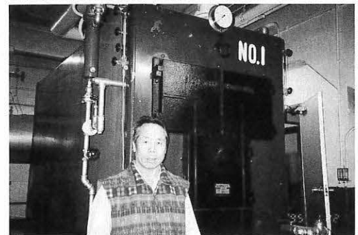
ボイラー室での筆者
