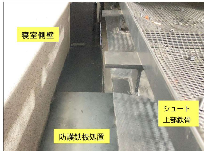
写真-3 寝室側壁面～シュート上部鉄骨(拡大) 処置後
