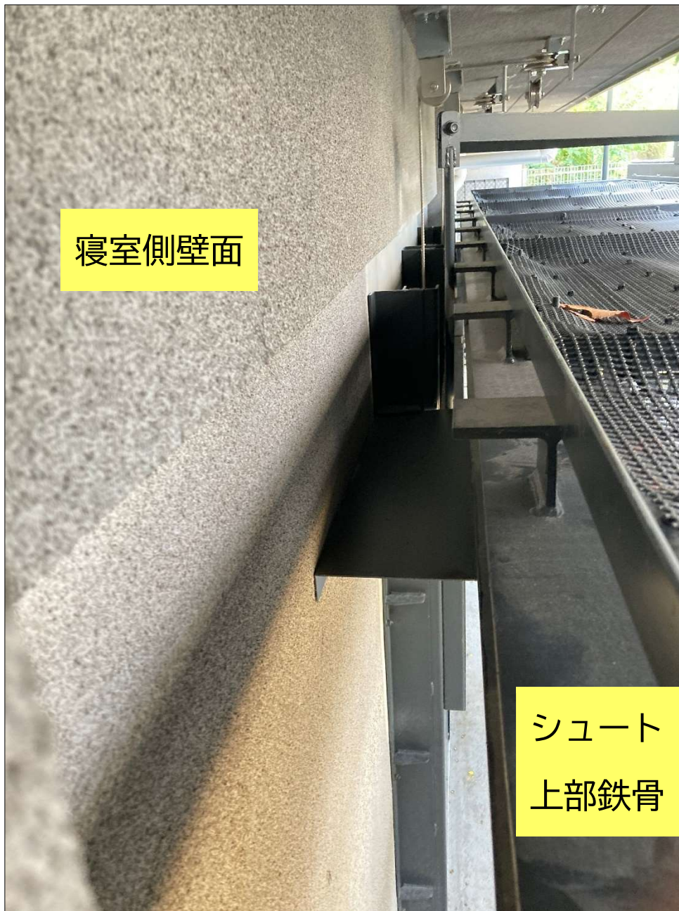
写真-1 寝室側壁面～シュート上部鉄骨
